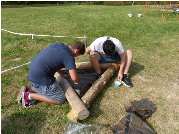
Instalace geotextílie
